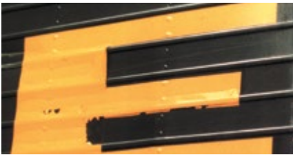
Die Folie ist nicht geeignet für welligen Untergrund und hat sich vom Blech gelöst. Einreißen ist die Folge.
